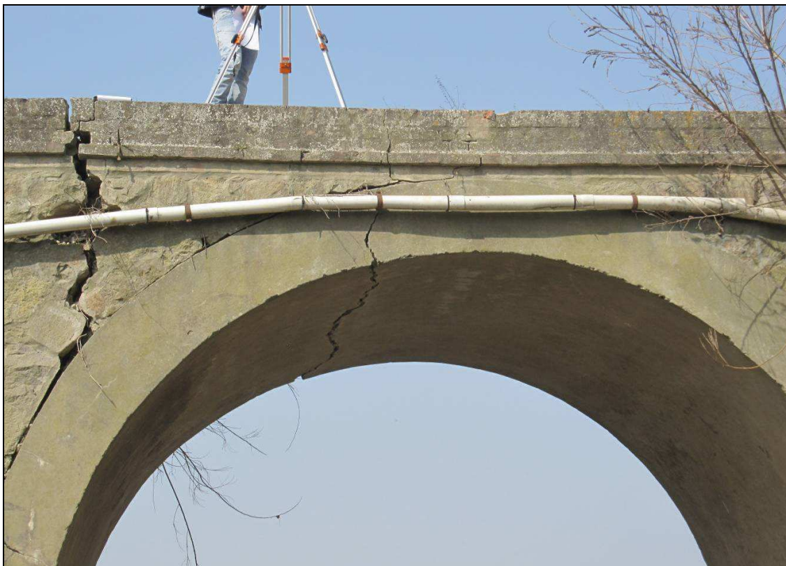
Dettaglio della fessura posta al di sopra del piedritto sinistro
