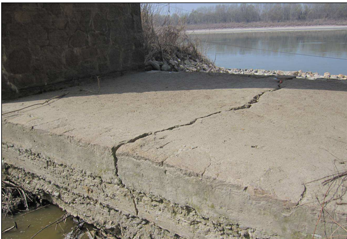
Vista da monte del basamento il cls sotto cui attualmente scorre il canale nei periodi di magra
