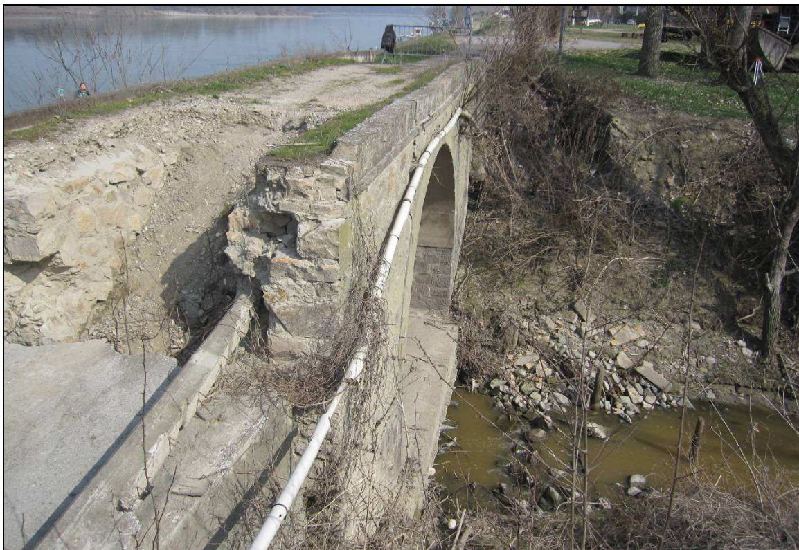
Vista Ponte da argine sinistro Fossetta dell'Abate (sulla sinistra la zona crollata)
